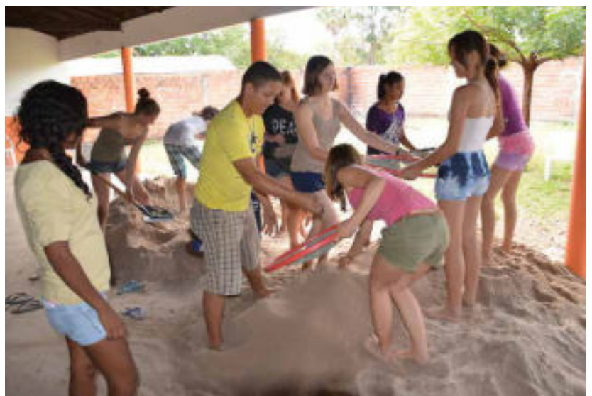
Abb. 4: Besuch in Brasilien: Gemeinsam sieben, mischen und pressen die Jugendlichen Mauersteine für den Bau eines Unterstands auf der Plantage in Porto © Brasil09 e .V.
